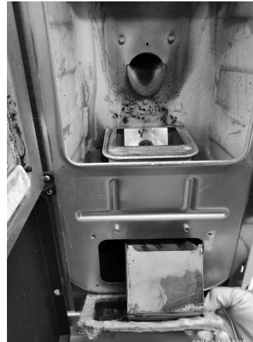
Fig. 34 - Retire la tapa de inspección
